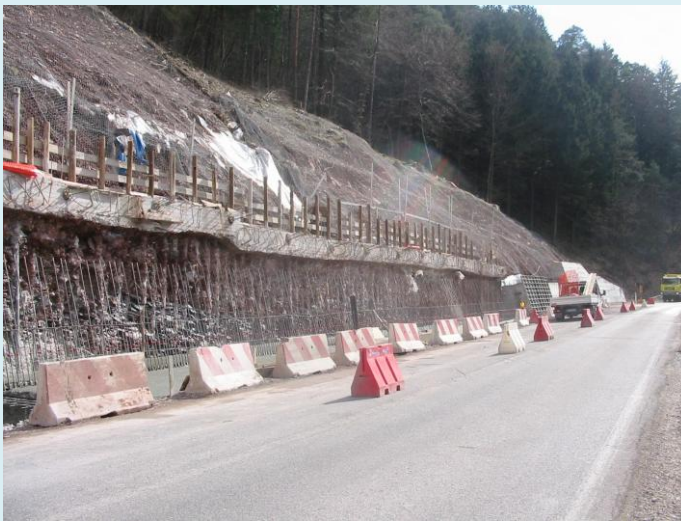
“berlinese” per muro di sostegno stradale
