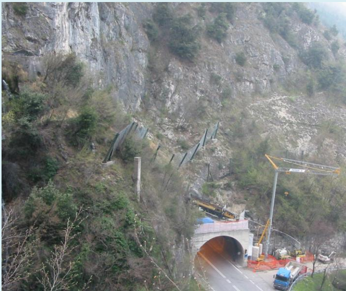
perforazione direzionale per acquedotto
