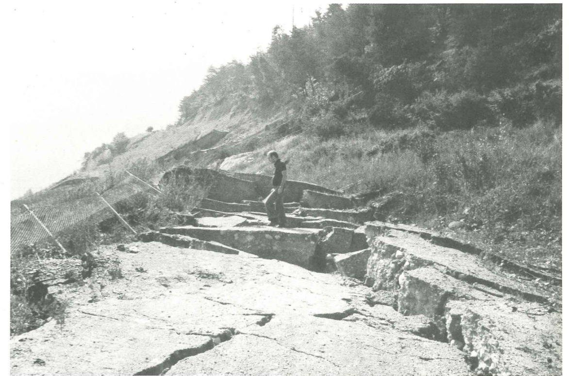
Foto 4 - Frana di Sardagna: in evidenza il sistema di crepe prodottesi.
