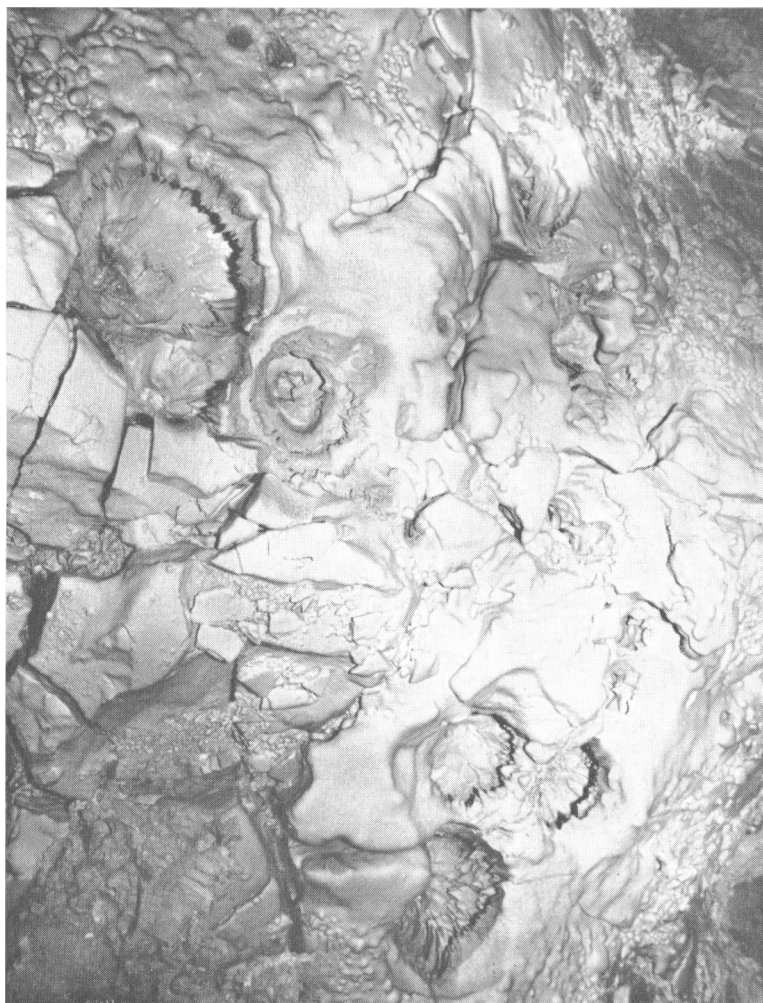
Foto 2 — Deposito melmoso sul pavimento della «sala» con effetti dello stillicidio e crepe dovute all'evaporazione superficiale.
