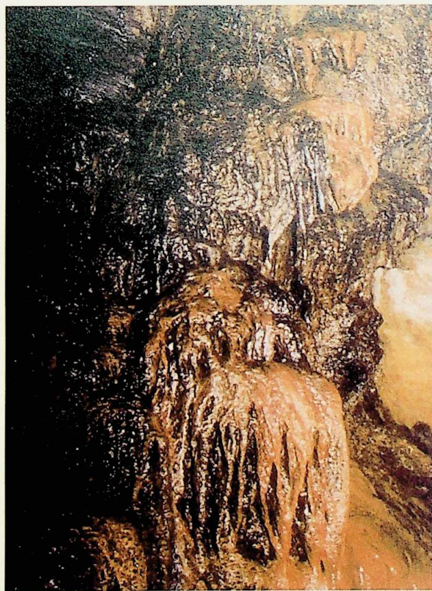
Fig. 13 - Galleria di Val Taviela. Concrezioni di ossidi ed idrossidi di ferro generati dall'acqua minerale effervescente naturale.
